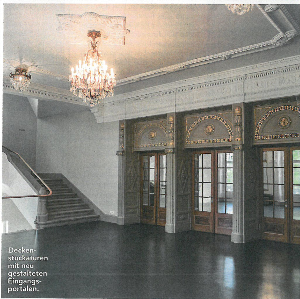
verkröpftes Eckgesims über erneuertem Wandpilaster als Kapitäl.
